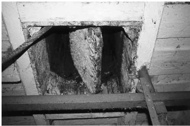
Ochranou před úhynem sov ve větracích šachtách odchoven dobytek je zajištění jejich stálého otevření ve spodní části šachty. Okolí Stuttgartu (Německo), 3. 7. 1999 Foto K. Poprachs
