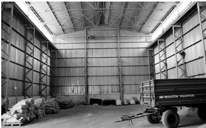
Sova pálená hnízdí v otevřených prosvětlených objektech, budka je instalována v horní části velkokapacitního seníku na železné konstrukci (instalace budky a její kontrola je v některých případech náročná), okres Znojmo, 4. 6. 1998
