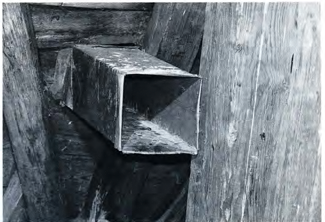
Obr. 12 - Upravený vstupní otvor pro sovu pálenou do věže kostela. Prodloužená roura zamezuje přirozeným způsobem přístup holubům. Dobré Pole, 13.5. 1994 (foto L. Opluštil). Fig. 12 - Adapted opening in the church tower prevents the entrance of pigeons. Dobré Pole village, 13.5. 1994 (photo L. Opluštil).
